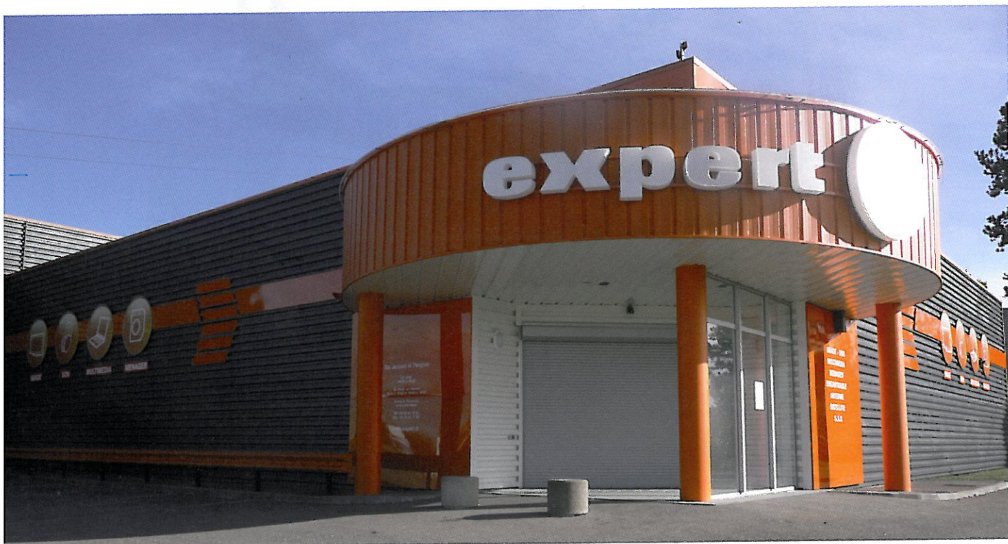
Le magasin de Haudainville, à l'enseigne flambant neuve, prêt à ouvrir ces portes
